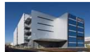
FA制御機器新生産棟
